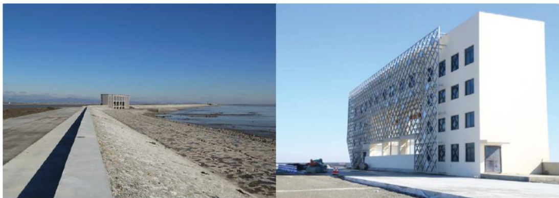
图 3.4-3a 龙湾二期海堤、水闸现状图
